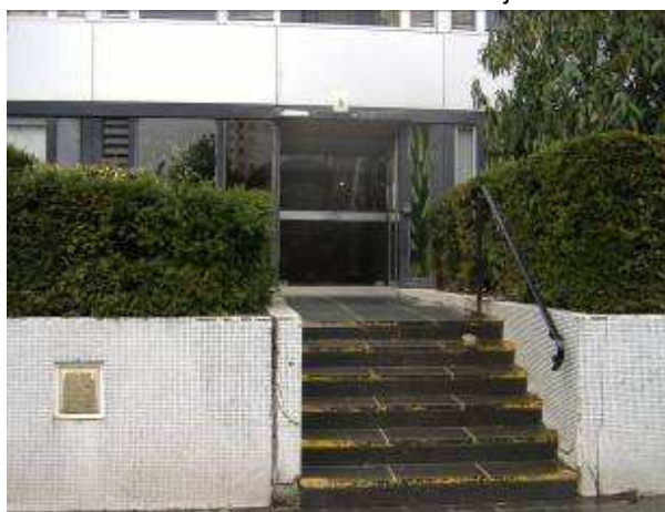
Escalier extérieur K (V4 2463) Fissures traversantes sur murets de jardinières
