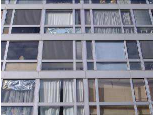
Détail de la façade rue C.R Mouchotte Les résidents ont mis des voiles réfléchissants (V1 1744)
