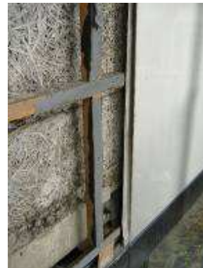
Bandeau horizontal au 1 er étage escalier C Vue de détail de l'isolant et cadre de fixation (V206533)
