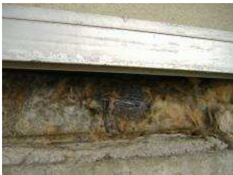
Bandeau horizontal au 2ème étage escalier C Vue de détail du mode de fixation et la poutre métallique de fixation au niveau du sol (V19 6467)
