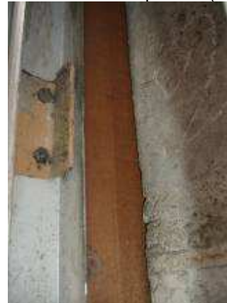
Bandeau vertical (1 er étage escalier C) mode de fixation au mur porteur (V19 6484)
