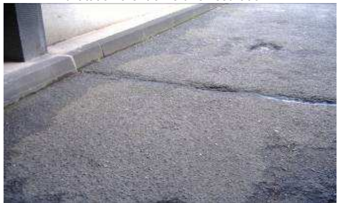
Dalle-terrasse Modigliani (V17P1 5582) Accès par la rampe handicapés depuis la rue jusqu'à la terrasse Modigliani. L'absence du joint de dilatation a entraîné une fissuration.
