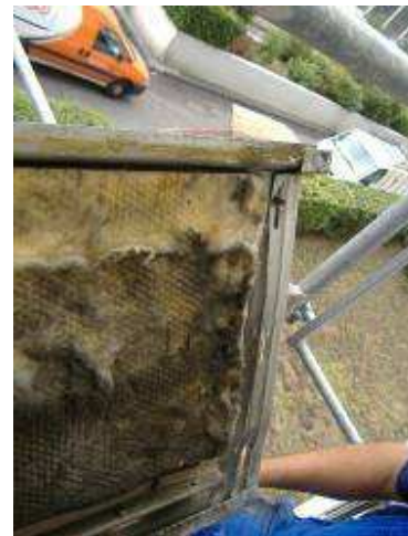
Bandeau horizontal au 2 e étage escalier C Vue de détail de l'isolant sur le capot (V19 6503)
