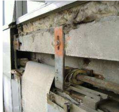
Bandeau horizontal au 2ème étage escalier C Vue de détail du mode de fixation et store roulant au droit de l'ouvrant (V19 6465)
