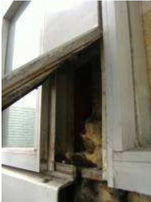
Bandeau vertical (1 er étage escalier C) Pièce de fixation des façades au mur porteur (V19 6499)
