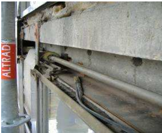
Bandeau horizontal au 2ème étage escalier C Vue de détail du mode de fixation et la poutre métallique de fixation au niveau du sol (V19 6467)
