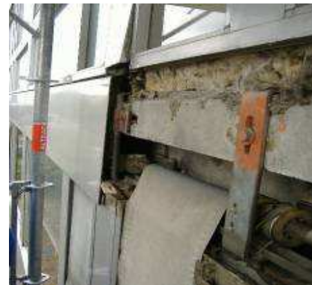
Bandeau horizontal au 2ème étage escalier C Vue de détail du mode de fixation et store roulant au droit de l'ouvrant (V19 6465)
