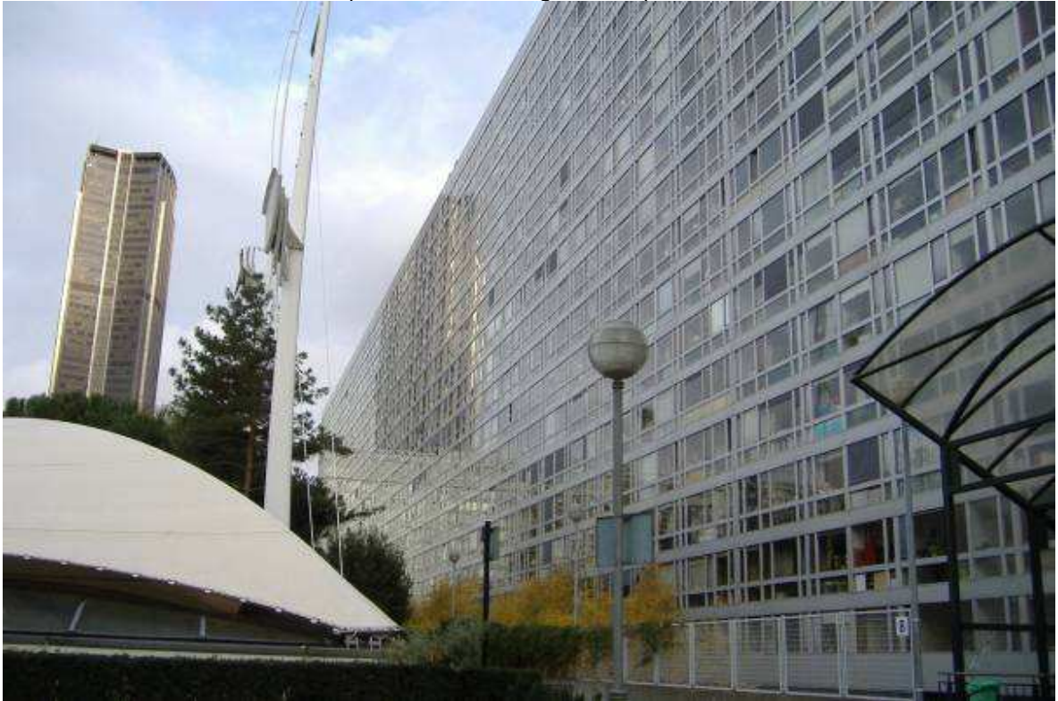
Vue générale de la façade Nord-Est (V1 1654) Depuis la dalle sur la gare Montparnasse
