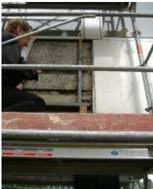
Bandeau horizontal au 1 er étage escalier C Vue de détail de l'isolant et cadre de fixation (V206528)
