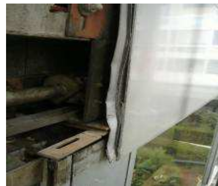
Bandeau horizontal au 2ème étage escalier C Vue de détail du mode de fixation des éléments de façade au plancher haut du 1 er étage (V19 6469)
